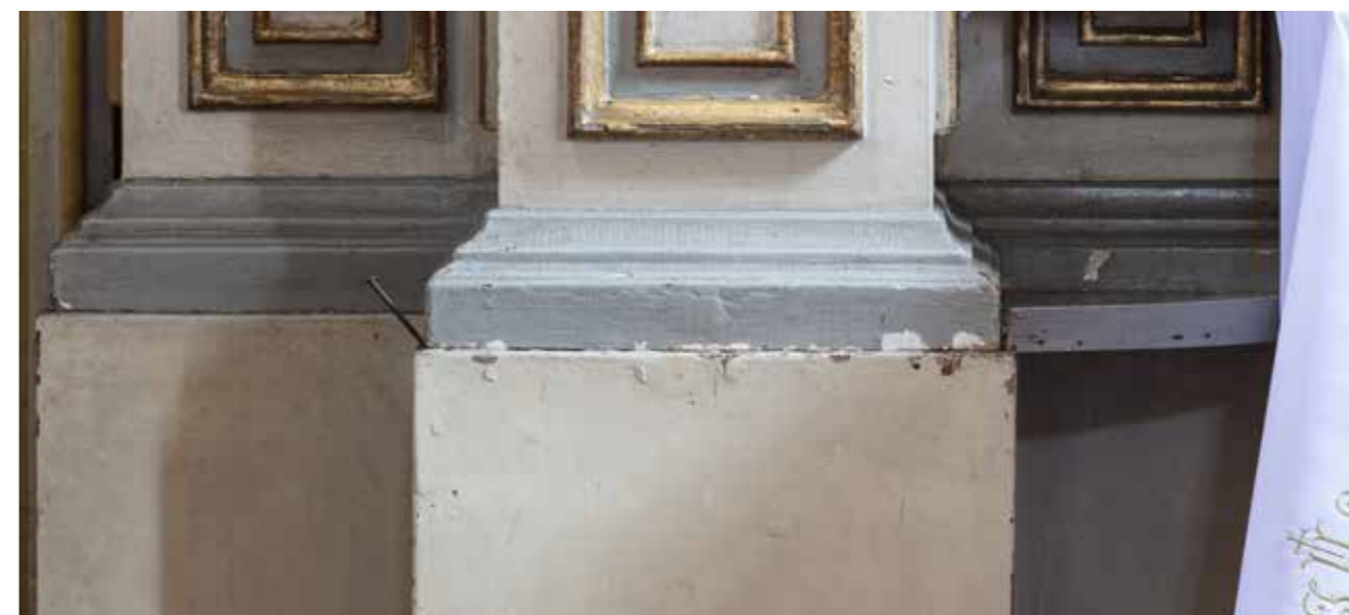
Dolny cokół ołtarza głównego. Widoczne rozległe ubytki do podłoża drewnianego oraz przemalowania formy farbami olejnymi
