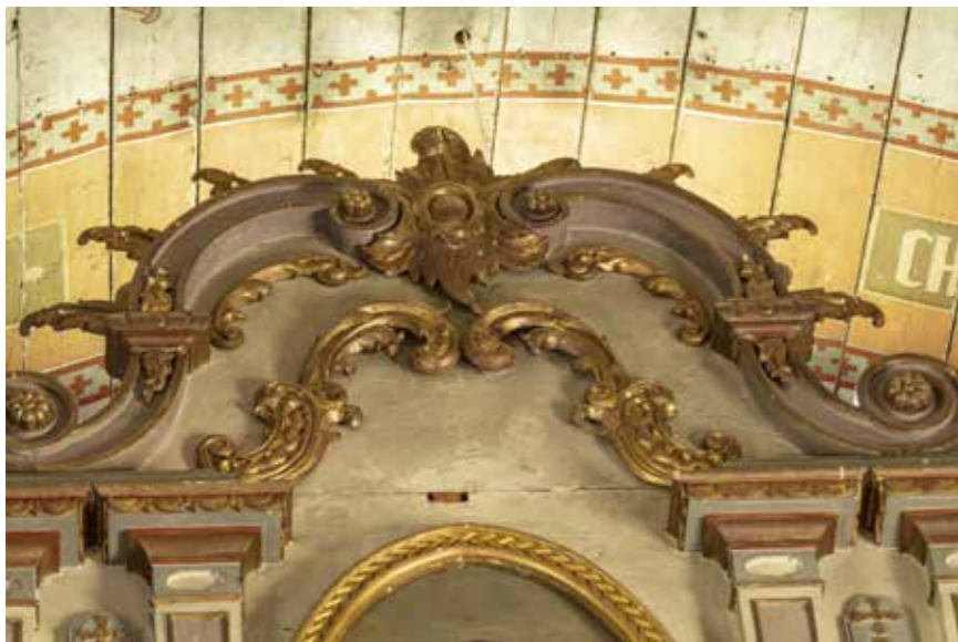
Zwieńczenie ołtarza głównego. Widoczne spękania i rozeschnięcia się połączeń stolarskich oraz zabrudzenia polichromii i wtórnej pozłoty.
